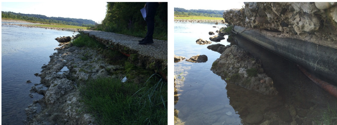
Figura 59: Dissesto di sponda in destra idrografica con l'esposizione della tubazione agli eventi di piena.
